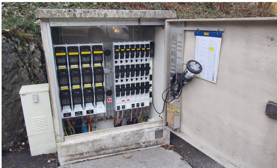
Erneuerte Verteilkabine, Stützliweg
