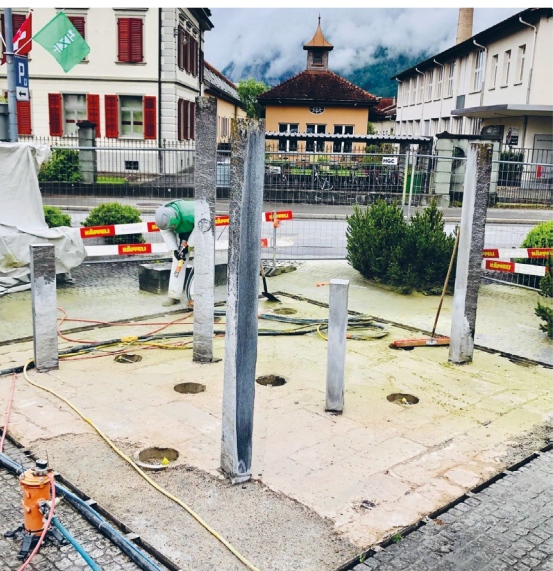
Sanierung Wasserspiel Bahnhofstrasse
