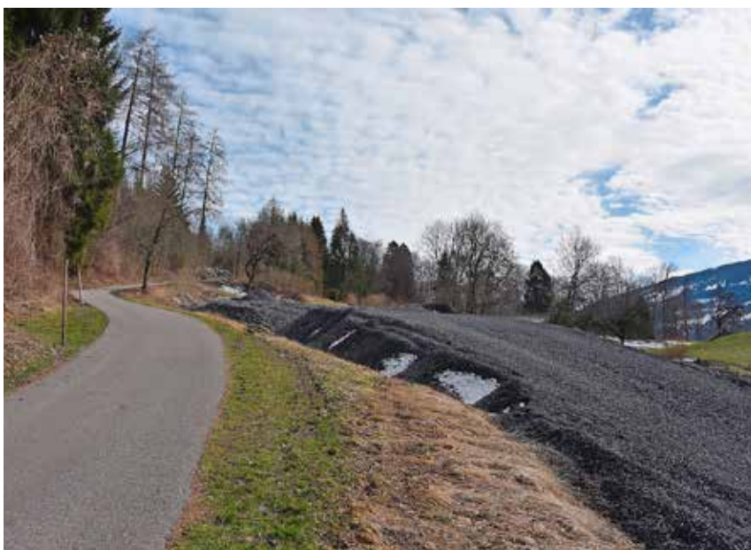
Sinnvolle Wiederverwertung: Deponiematerial, das bei den Arbeiten zum Wasserkraftwerk Berschnerbach angefallen ist, wird für die Sanierung der Strasse nach Sennis (links) verwendet.
